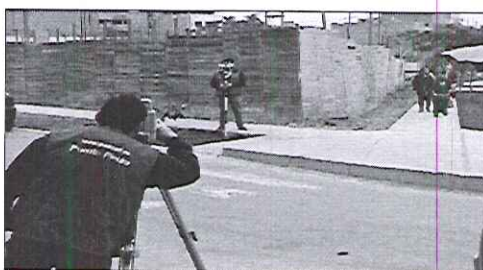
Levantamiento topográfico en la I.E.I "MI CELESTIAL JESÚS" para su proceso de Saneamiento físico legal.
