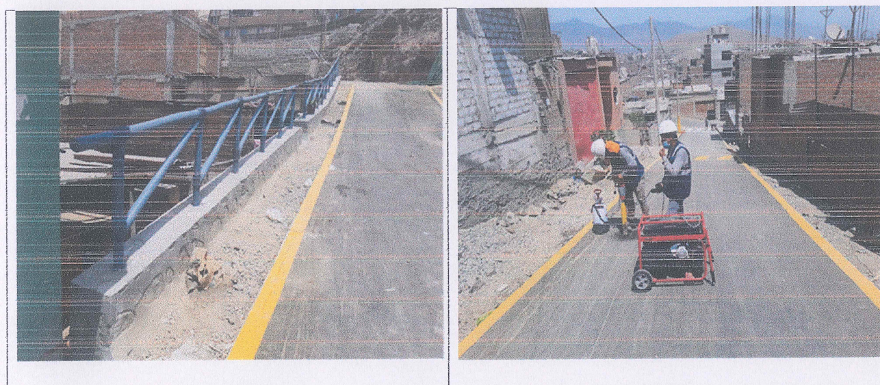
2441018: CREACION DEL SERVICIO DE TRANSITABILIDAD VEHICULAR Y PEATONAL EN LAS VIAS INTERNAS DE LA URBANIZACION LAS PALMAS - SECTOR ENSENADA - DISTRITO DE PUEDE PIEDRA - PROVINCIA DE LIMA - DEPARTAMENTO DE LIMA
