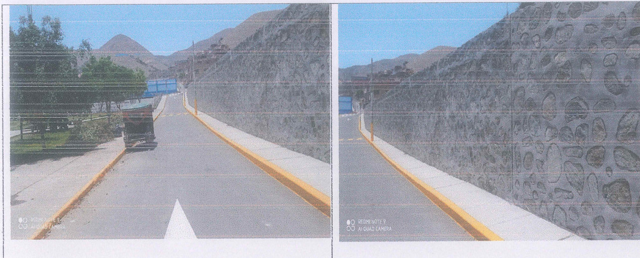
2368656: CREACION DEL SERVICIO DE TRANSITABILIDAD VEHICULAR Y PEATONAL EN LA CA. 3 ENTRE LA CA. 8 Y LA CA. 4 EN EL P.J. LADERAS DE CHILLON - I EXPLANADA - SECTOR LADERAS PUEDE PIEDRA - DISTRITO DE PUEDE PIEDRA - PROVINCIA DE LIMA - DEPARTAMENTO DE LIMA
