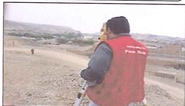
LEVANTAMIENTO TOPOGRÁFICO EN EL ASENTAMIENTO HUMANO "BUENOS AIRES PERÚ" PARA SU POSTERIOR COLOCACIÓN DE HITOS Y DEFINICIÓN DE SUS LÍMITES POR LA PARTE SUR.
