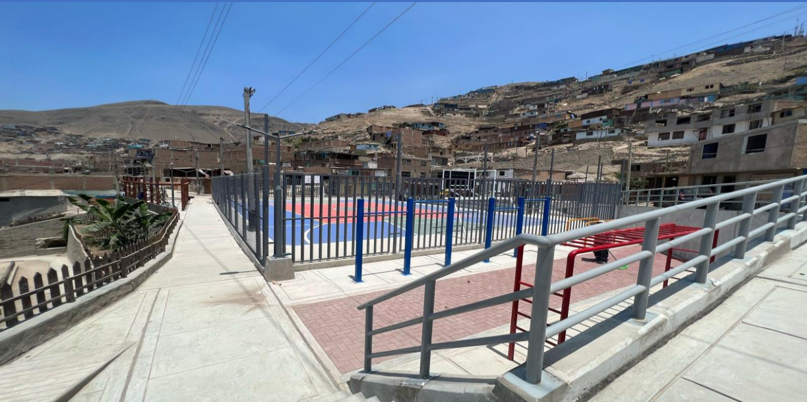
LOSA DEPORTIVA MZ.W LT.01 EN EL A.H. VISTA ALEGRE S/ 520,061.00
