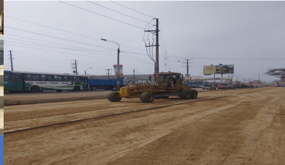
PISTAS Y VEREDAS EN LA VÍA AUXILIAR DE LA PANAMERICANA S/ 5,248,912.00
